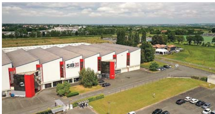
Trop à l'étroit dans ses locaux à une période où l'activité explosait, SIB a transféré sa production en 2001, dans cette ex-usine de Janneau. Agrandi pour installer un transstockeur, en 2011, puis pour faire de la place à l'expédition et au montage des portails, en 2016, le bâtiment totalise 20 000 m 2 et abrite bureaux et ateliers.
